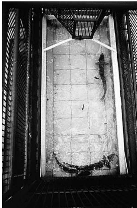
Abb. 11: Lachse im Unterkorb eines Fischaufzugs
