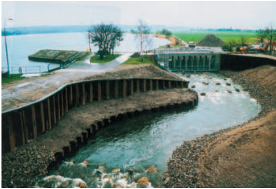
Abb. 9: Raugerinne-Beckenpass am Wehr Rathmannsdorf (Lachsbach, Sachsen)
