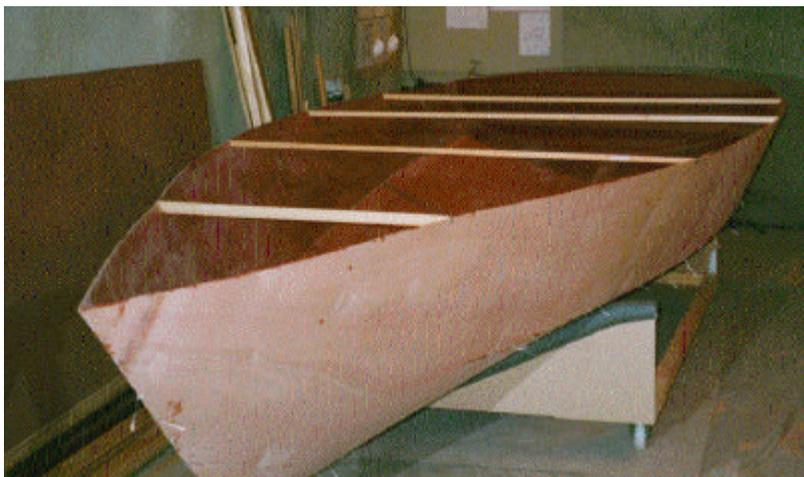
Legen sie eine weitere Latte auf den Rumpf ungefähr an der Stelle, wo die Spreizlatte hin soll und messen sie die Position mit einem Bandmaß vom Bug her exakt aus. Bohren sie ca. 1,5cm unter dem Rand ein Loch in Seitenplatte und schrauben dadurch die Spreizlatte mit einer
