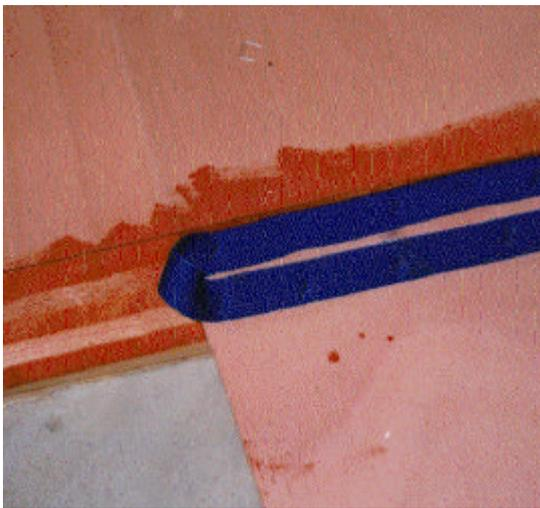
Zum Fixieren und pressen benutzen sie am besten einen kräftigen Hand- oder Elektrotacker (Werkzeugverleih). Ein untergelegter alter Spanngurt schont die Holzoberfläche und macht das spätere Ziehen der Klammern zum Kinderspiel. Setzen sie über die gesamte Fuge alle 5cm ein bis zwei Klammern, jeweils 1cm vom Rand der Naht. Falls der Tacker genug Power hat, heften sie ruhig bis in die untergelegte Latte hinein.
